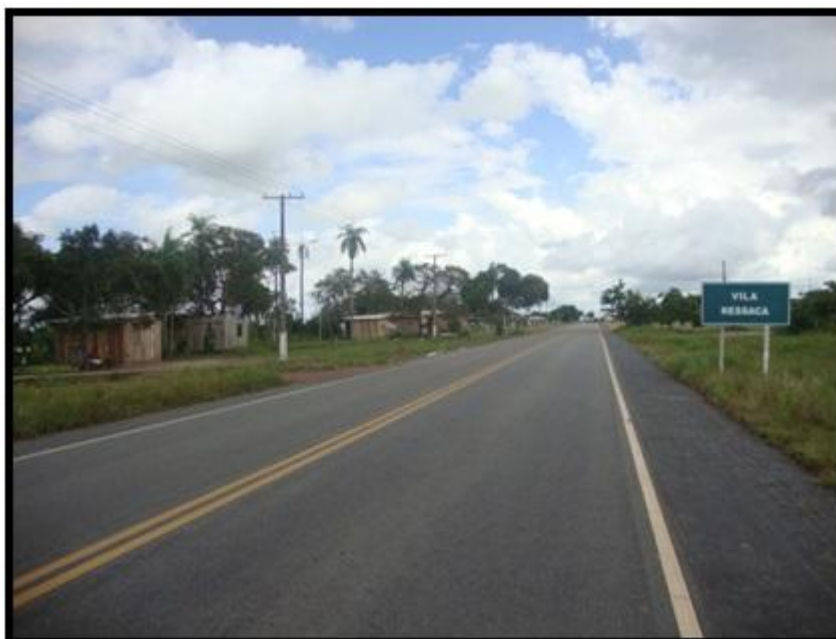
Figura 2 - Rodovia EAP 070, principal via de acesso a Vila Ressaca da Pedreira-AP.
