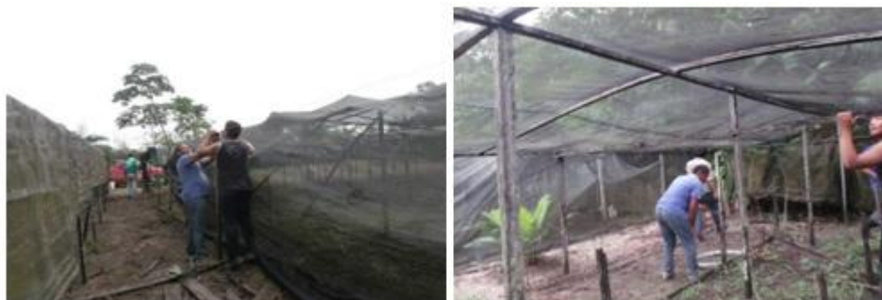
Figura 33. Detalhes das estruturas e equipamentos montados.
