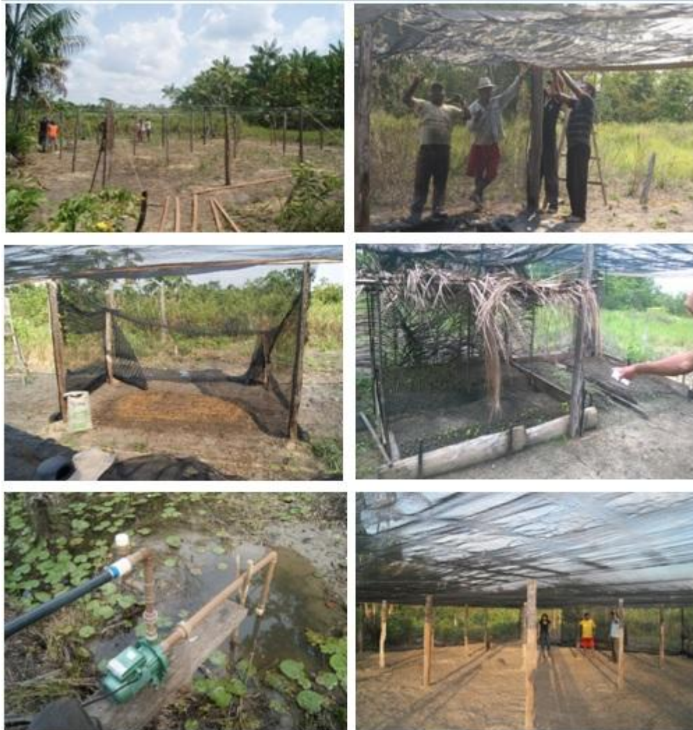
Figura 27. Detalhes das estruturas e equipamentos montados.
