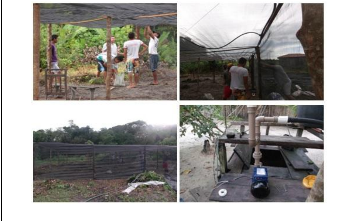
Figura 32. Detalhes das estruturas e equipamentos montados.
