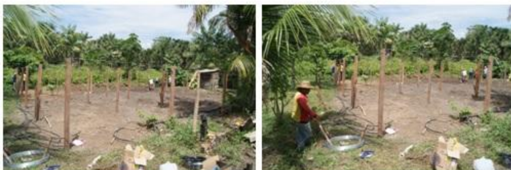
Figura 28. Detalhes das estruturas e equipamentos montados.
