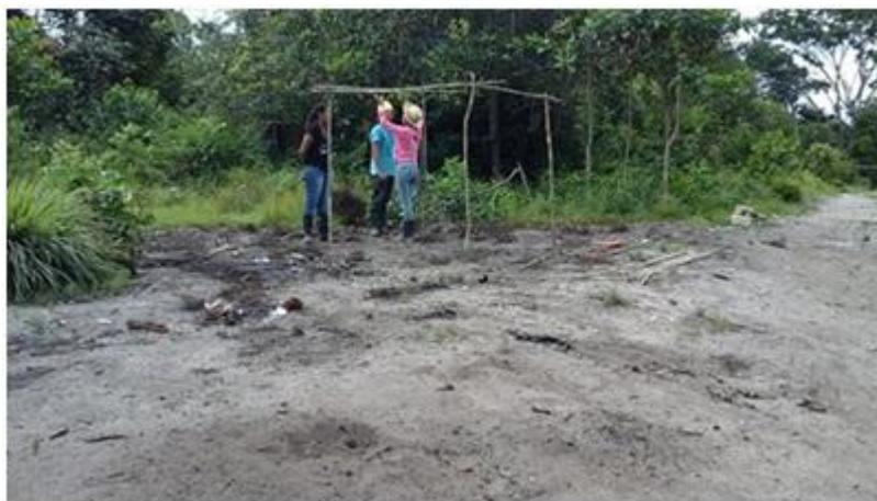
Figura 9: Construção do viveiro de mudas da comunidade Anjo da Guarda.
