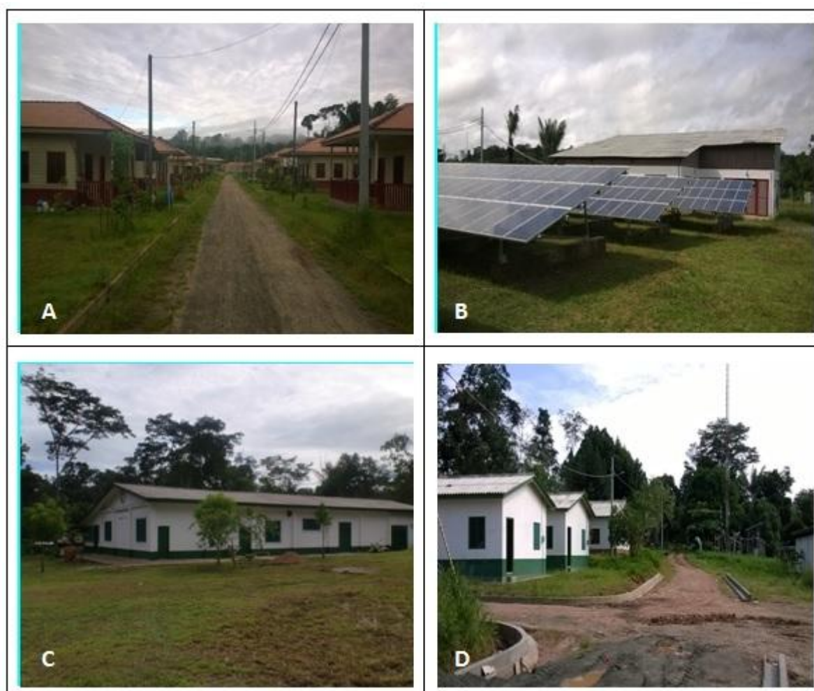
Figura 3 - Nova vila (A), Sistema de energia Fotovoltaica (B), (C), novo prédio da COMARU (D) novas instalações da COMARU
