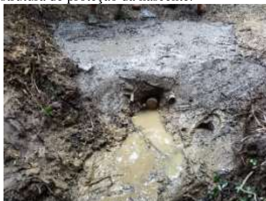
Figura 4. Processo final da estrutura de proteção da nascente.
