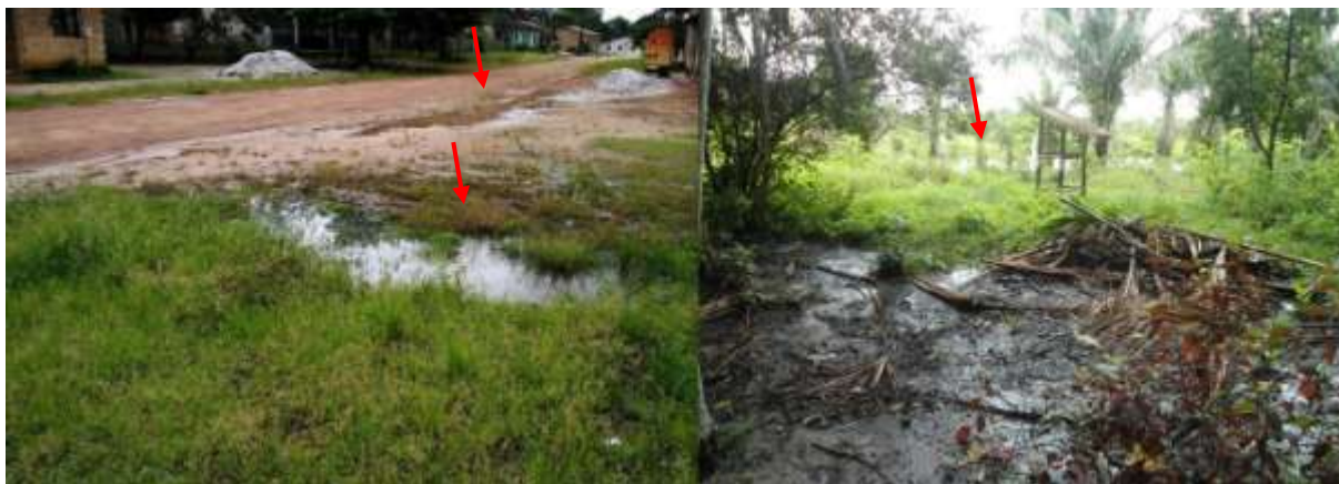
Figura 4: Pontos de alagamentos ocasionados pela falta de drenagem de águas pluviais e ocupação desordenada do solo na comunidade de Segredinho, no município de Capanema-PA.
