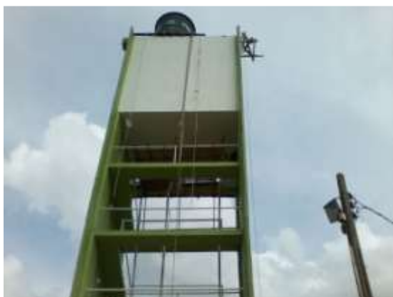
Figura 01. Vista da estrutura em concreto do reservatório desativado, sobre a mesma as duas caixas de fibra em uso para armazenamento de água.
