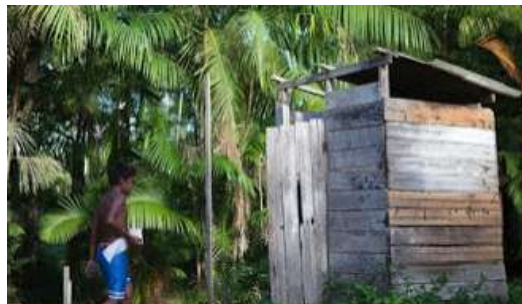
Figura 4. Banheiro Utilizado pelos Ribeirinhos
