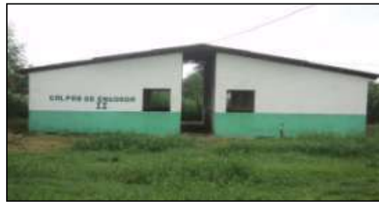
Figura 04. Vista do galpão II de engorda dos suínos. Sua cobertura mede 10,5 m x 11 m.
