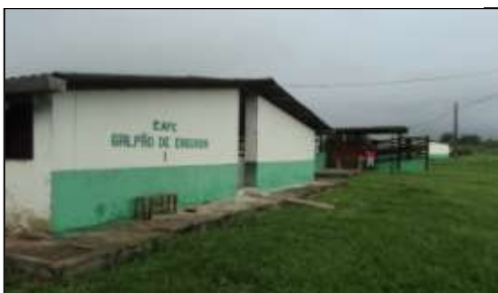
Figura 01. Vista do galpão I de engorda dos suínos. Está cobertura mede 10,5 m x 13 m.
