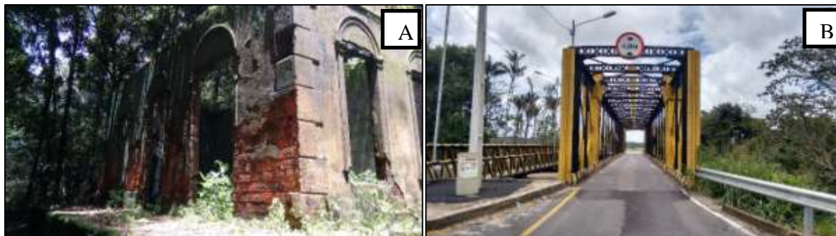
Figura 3. Ruínas da antiga estação (a) da estrada de ferro que ligou Belém à Bragança até o ano de 1964, (b) ponte de ferro sobre o rio maracanã.
